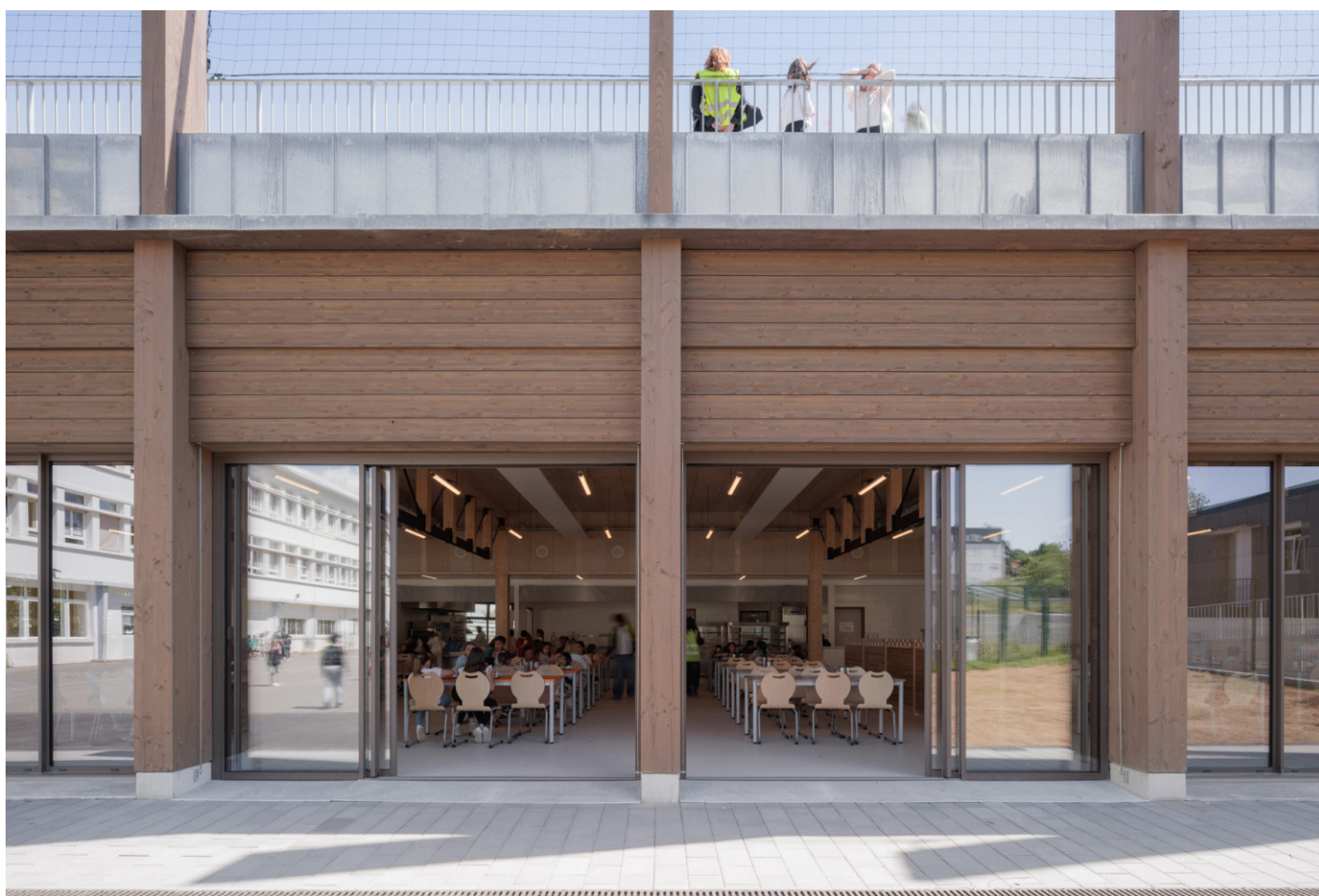
Les châssis coulissants du réfectoire élémentaire en liaison avec la cour d'école
