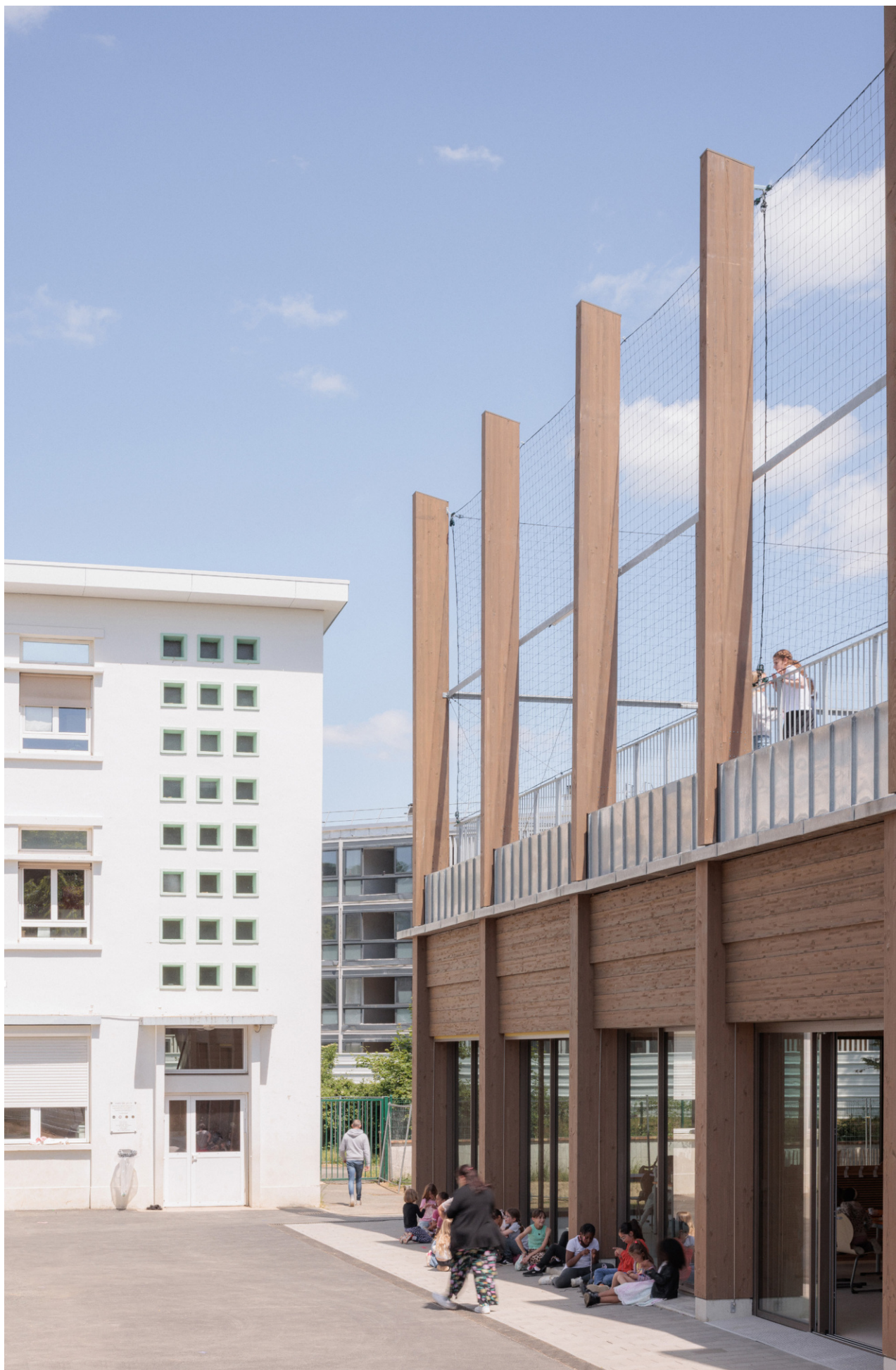
Vue de la façade ouest
